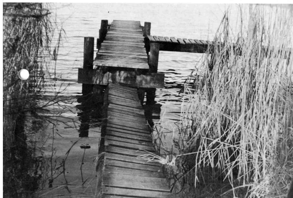
Im Gegensatz zu den soliden Fischerstegen an anderen Seen (z. B. Türlensee) sind diese am Pfäikersee überaltert und müssen ersetzt werden.
