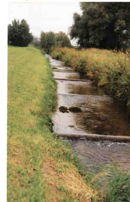
Der Chämtnerbach zwischen Kempten und Auslikon: Ein trostlos strukturarmes Gerinne. Bei Niederwasser ist es für aufwärtswandemde Fische schlecht zu passieren. Eine mäandrierende Niederwasserrinne mit Stein- und Holzstrukturen würde auch als Lebensraum für Fauna und Flora viel bringen.
